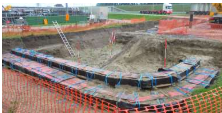
houten bekisting (dicht en gevuld)
