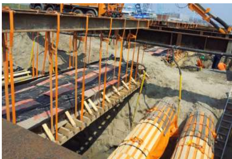
combinatie H balk en houten bekisting (gevuld)
